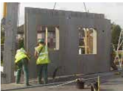
Изготовление стеновых панелей по технологии VST
