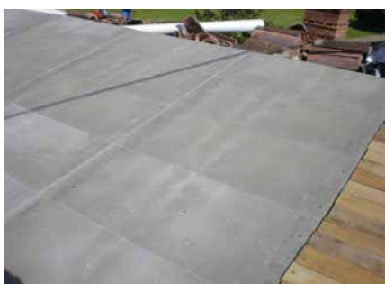
Изготовление оснований под кровлю
