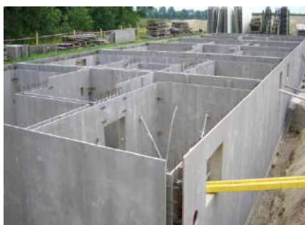
Изготовление несъемной опалубки
