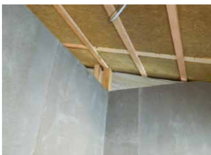
Внутренняя обшивка каркасных конструкций
