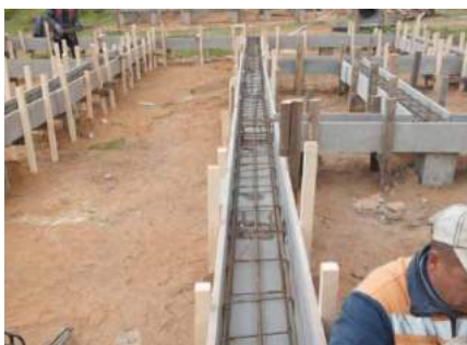
Изготовление фундамента с использованием несъемной опалубки
