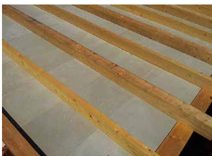
Подшивка крыши на деревянном каркасе
