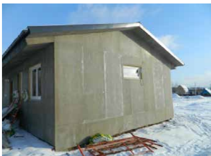
Наружная обшивка каркасных конструкций
