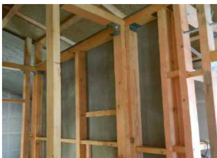
Изготовление внутренних (межкомнатных) перегородок
