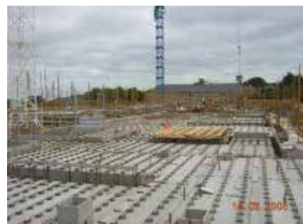
Изготовление панелей перекрытий по технологии VST
