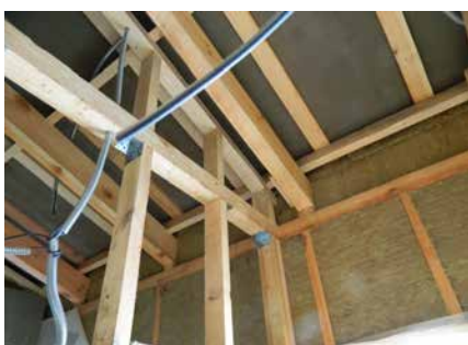
Изготовление оснований под кровлю
