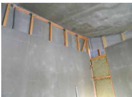
Внутренняя обшивка каркасных конструкций
