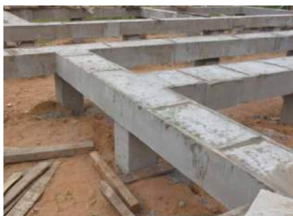
Изготовление фундамента с использованием несъемной опалубки
