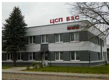
Изготовление вентилируемых фасадов
