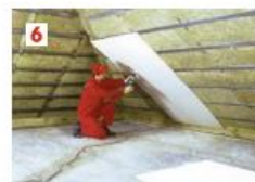
6. Монтаж пароизоляции (при необходимости) и облицовка мансардного помещения
