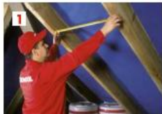
1. Измеряем расстояние между стропилами
