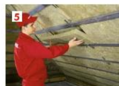
5. Укладка второго слоя утепления под стропилами
