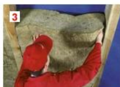
3. Укладка первого слоя утепления между стропилами
