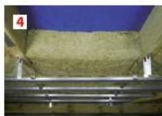
4. Монтаж стального каркаса
