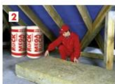
2. Подгонка плит из минваты Rockwool
