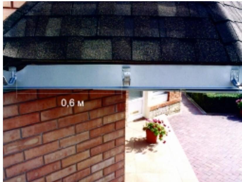
2. Крюки желоба размещаем на одинаковом расстоянии. Максимальное расстояние между крюками 0,6 м.
