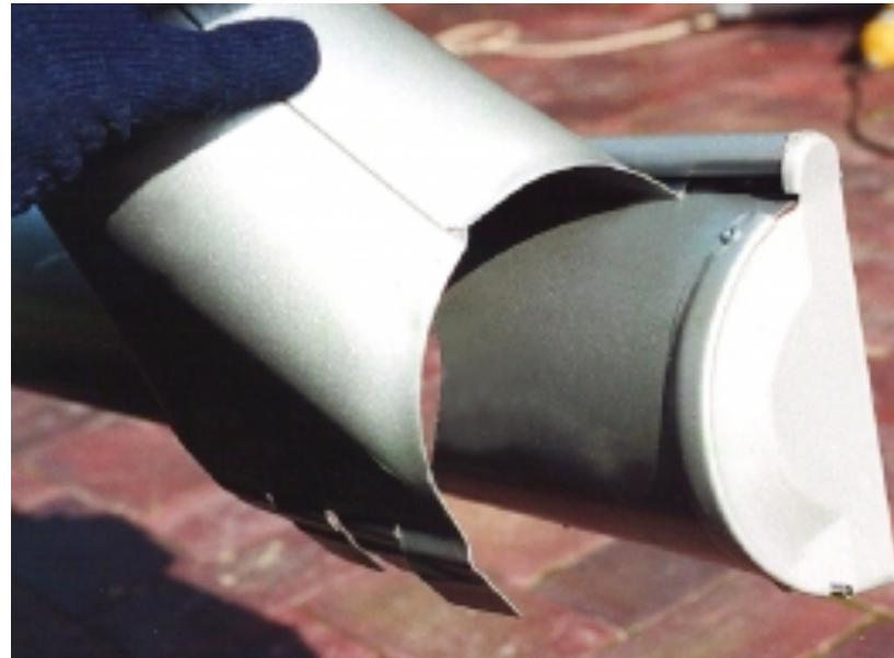
5. Устанавливаем водоприемник на выпиленное ножковкой отверстие. Загибаем язычки вокруг краев желоба. Закрепляем желоб в предназначенных для него крюках круглым краем наружу.
