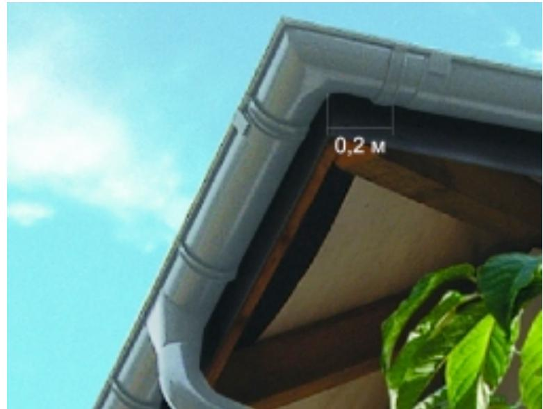
9. Поворотный угол крепится между двумя крайними держателями.
